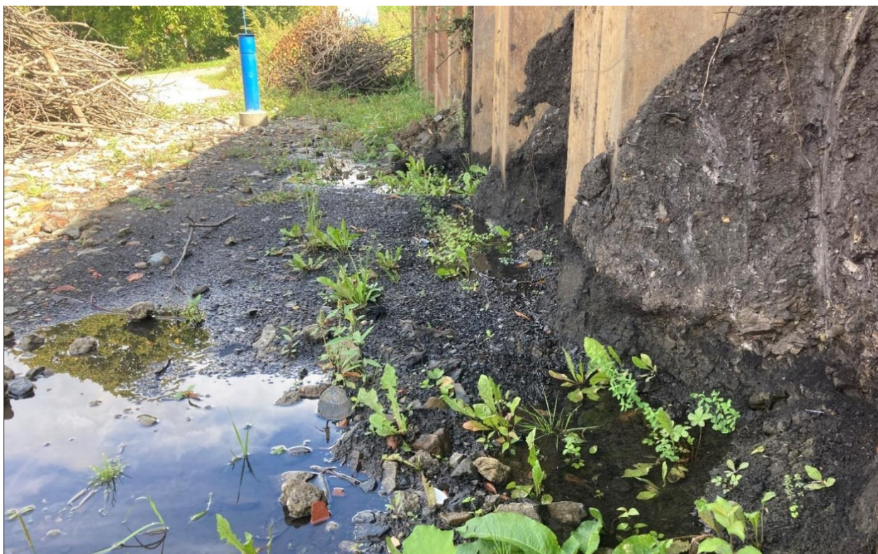
Obrázek 17 Průsak vody přes štětovnicovou stěnu (září 2022)
