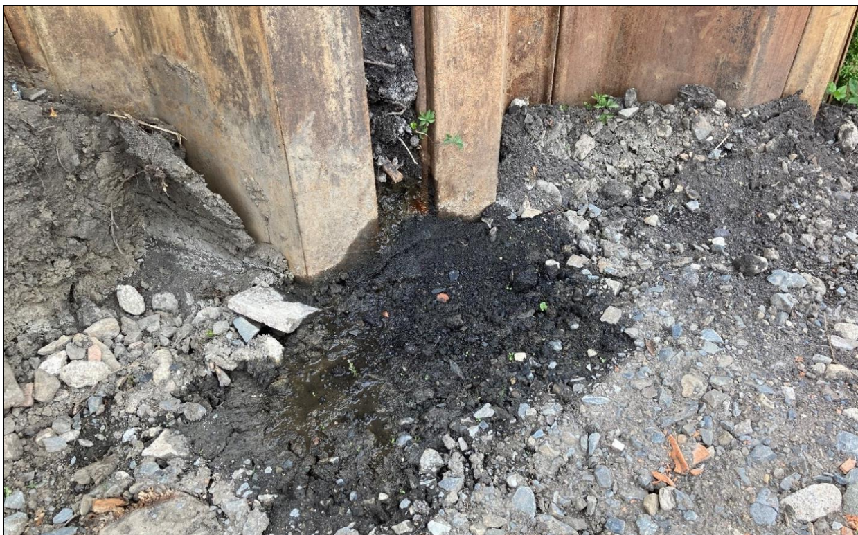
Obrázek 17 Průsak vody přes štětovnicovou stěnu (září 2022)
